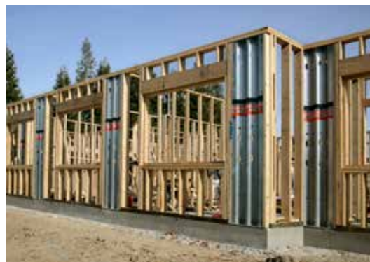
Voorbeeld van houtskeletbouw met Steel Strong-Wall™
