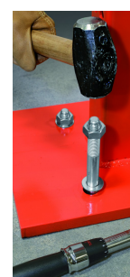
Fixation de structure métallique
