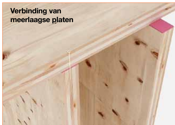
Verbinding van vloerplaten op dwarsbalken.
