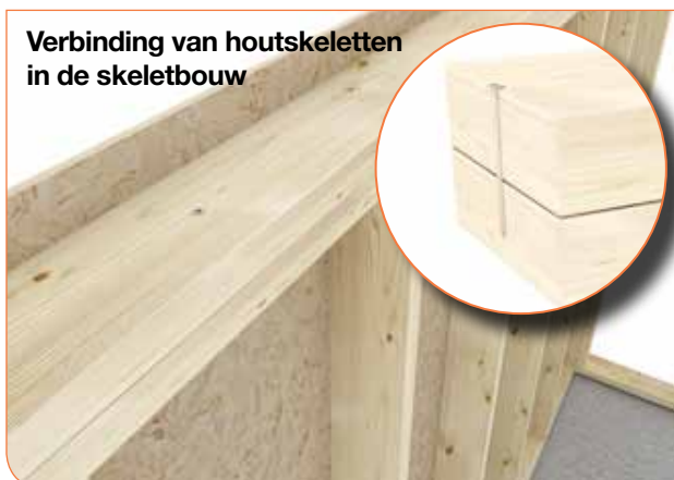
Verbinding van meerlaagse platen
