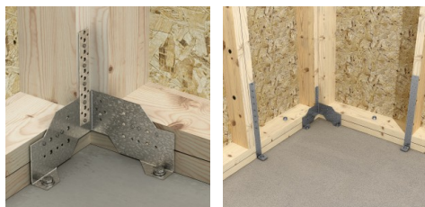
Verbinding van de houtskeletmuren op betonplaat
